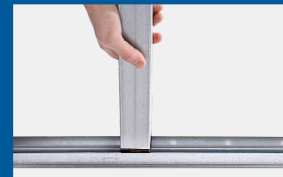
↑ Inserire il montante ad altezza totale nel binario sul soffitto e fissare a scatto sia sulla parte superiore che sulla parte inferiore.
