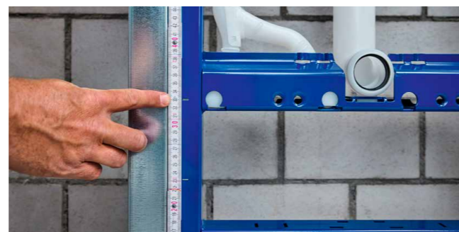
↑ Indicatori aggiuntivi sul telaio per ottenere visivamente l'altezza desiderata delle barre filettate e dello scarico.
