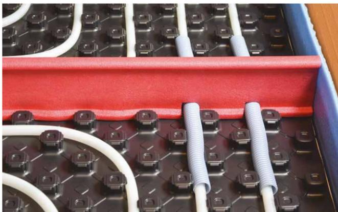
Il riscaldamento del pavimento non deve iniziare prima che siano passati 21 giorni dalla posa del massetto, e deve procedere con un aumento della temperatura di mandata massima di 5 °C per giorno. Sono da rispettare le norme di posa dei massetti.
